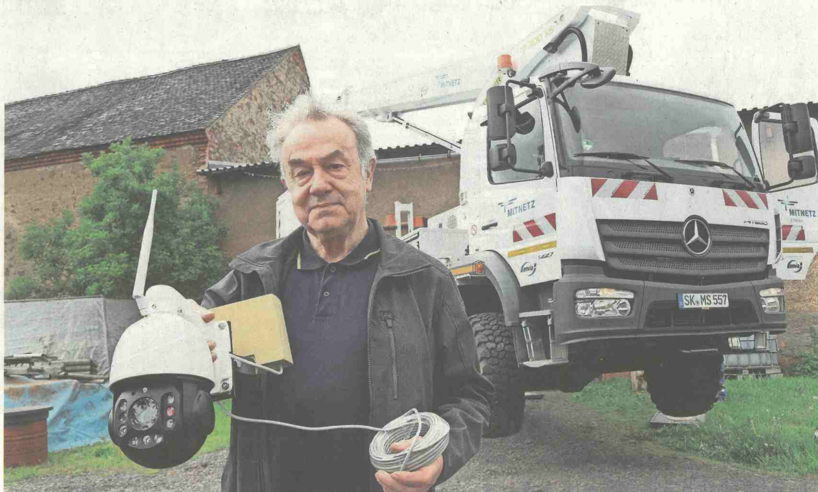
Der Otterwischer Storchenvater Klaus Döge zeigt die Zoom-Kamera, mit der nunmehr rund um die Uhr ins Großbardauer Storchennest gespäht wird. Mit dem Hubsteiger der Mitnetz wurde sie am Scheunendach nahe des Horstes angebracht.
